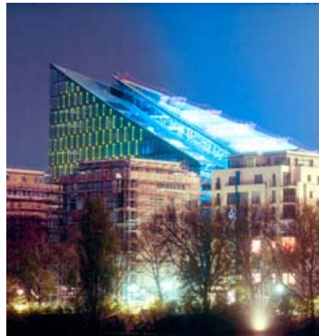
Die Badezimmer des exklusiven Frankfurter Wohnungsbauprojekts Solitaire (vorne im Bild) wurden mit JADO-Armaturen ausgestattet.
